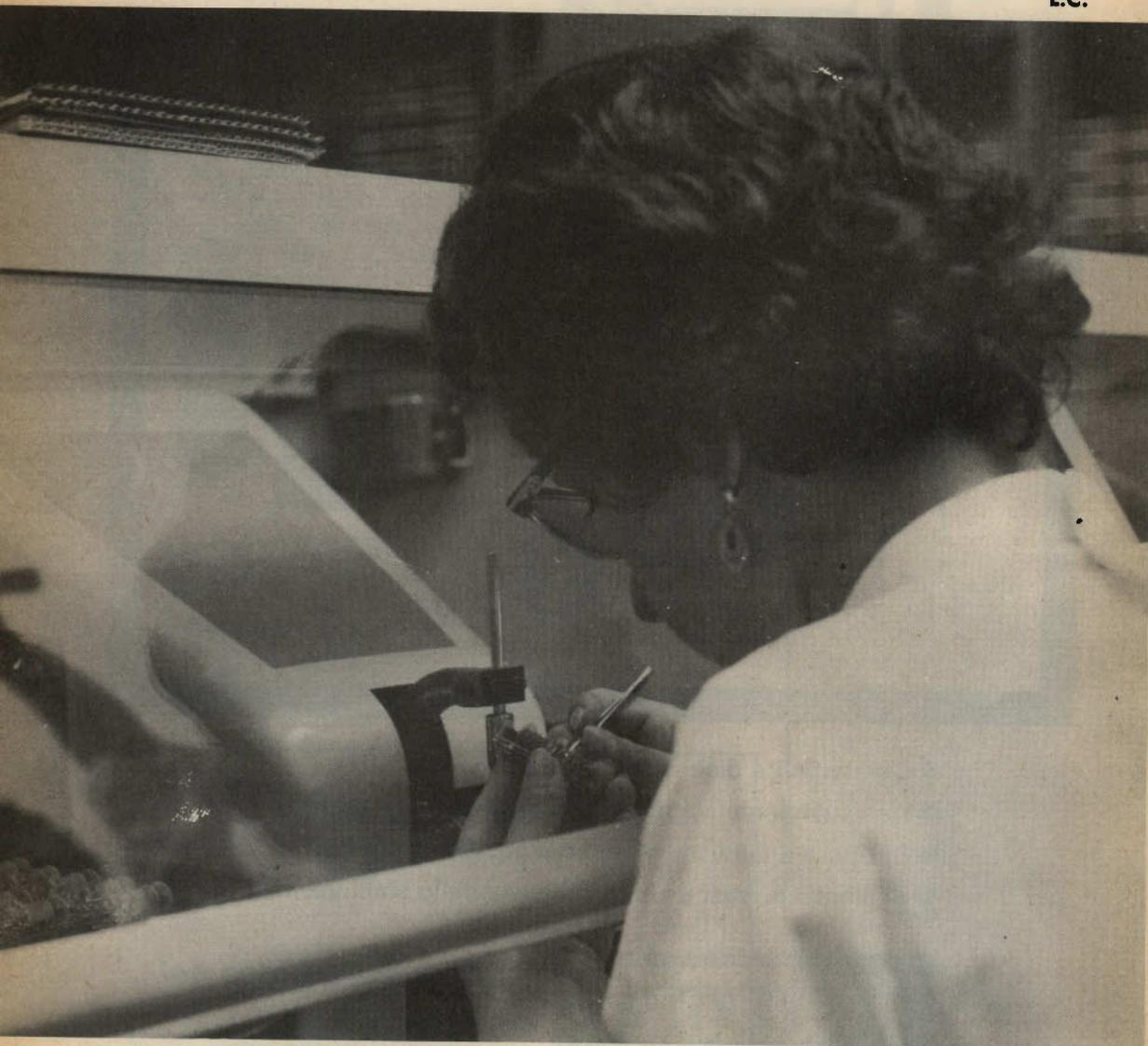
Montaggio del sistema elettrodoico delle nuove valvole a dieci piedini « DECAL » (Philips).
